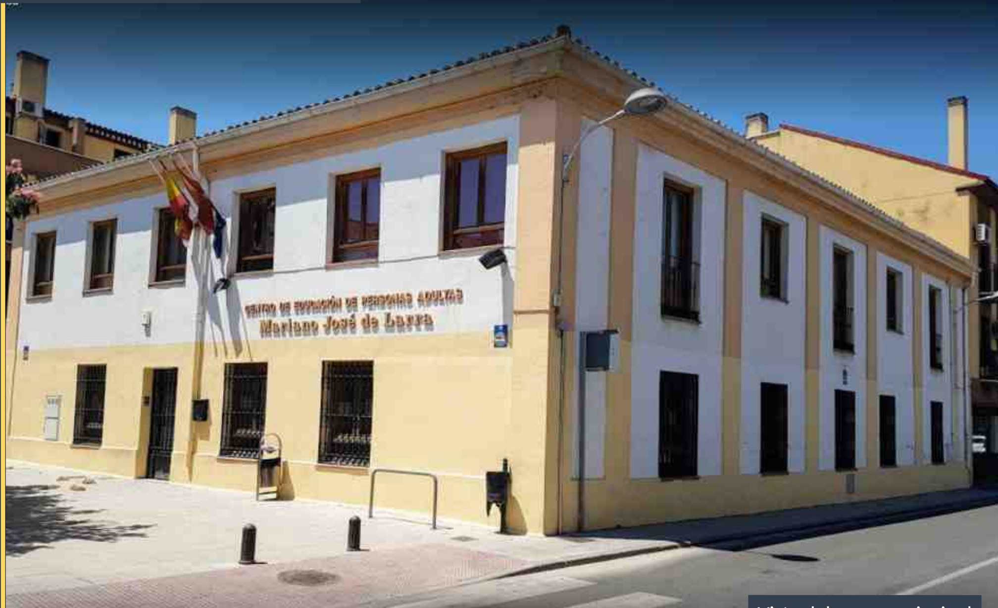
Vista del acceso principal
