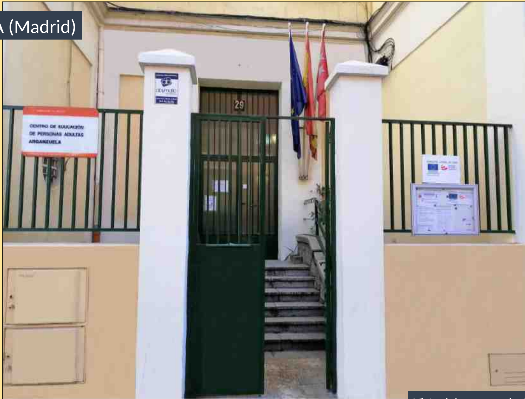
Vista del acceso principal
