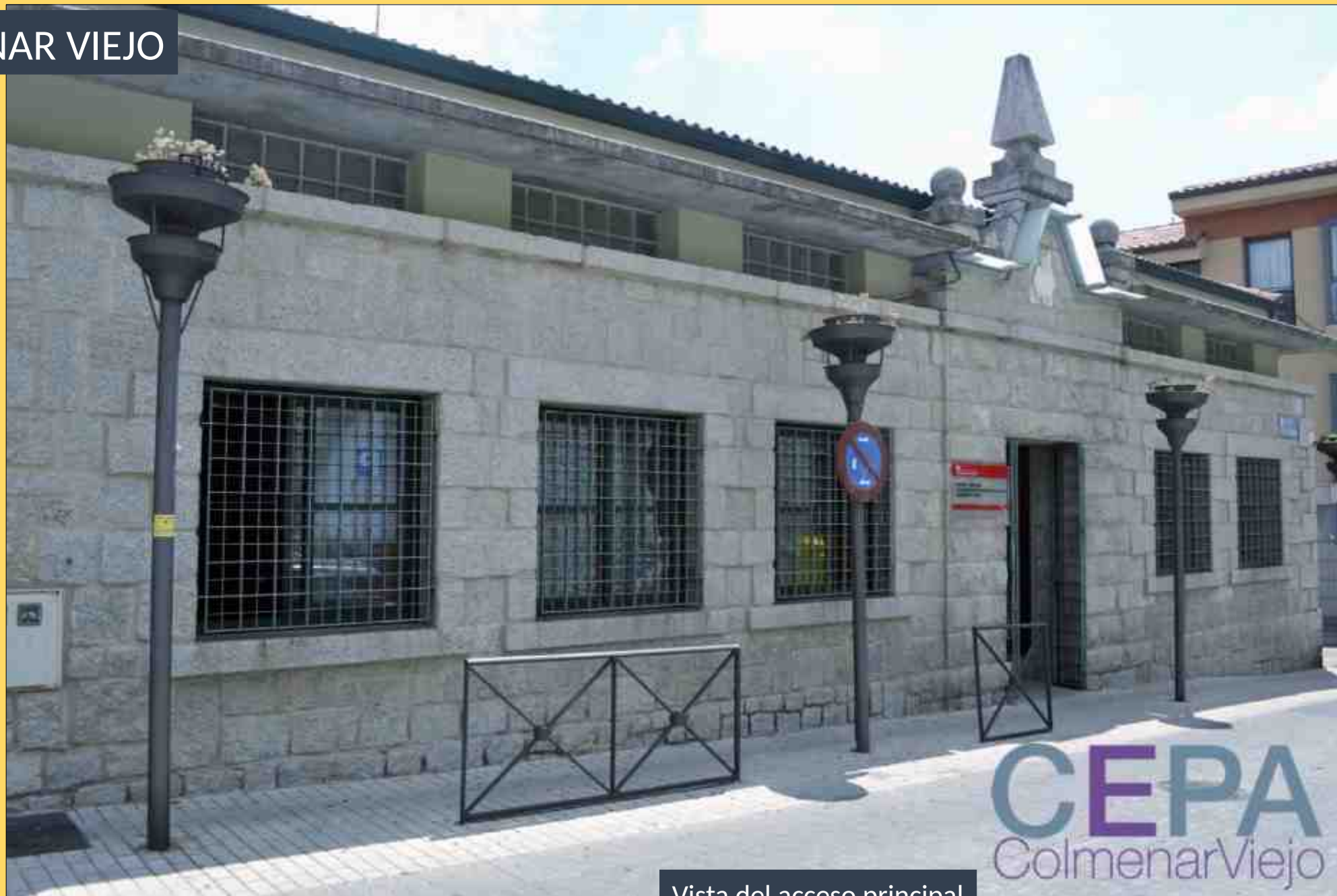
Vista del acceso principal
