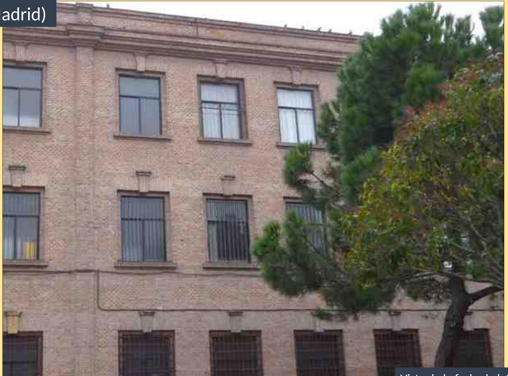
Vista de la fachada lateral
